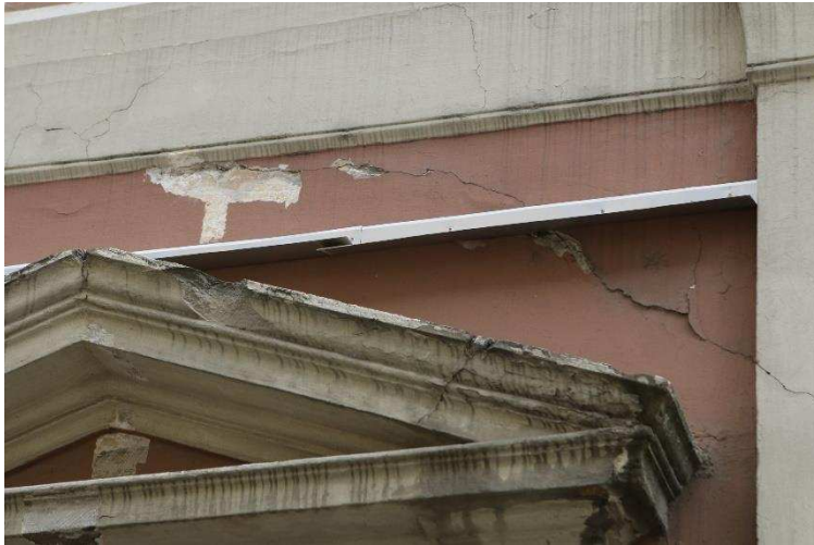
8. ábra: Szerkezeti repedés, Szent Imre római katolikus, Piarista Templom, Veszprém
