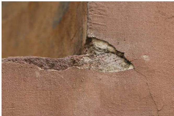
9. ábra: Szerkezeti elemek mentén létrejött repedés, Szent Imre római katolikus, Piarista Templom, Veszprém
