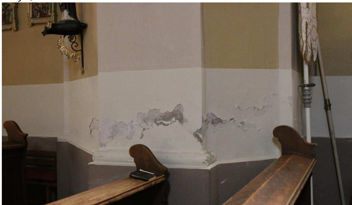
2. ábra: Talajvíz okozta sókivirágzás, Rákospalotai Szent János Főplébániatemplom, Budapest XVII. kerület
