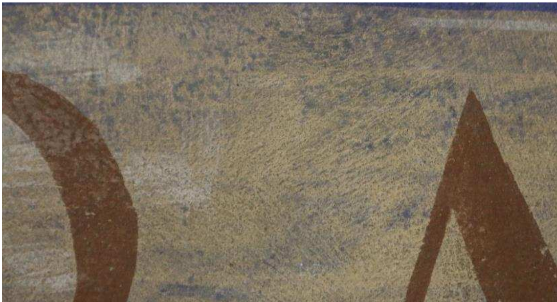
35. ábra: Törésnyomok a festett felületen, Magyarok Nagyasszony katolikus templom, Pécel
