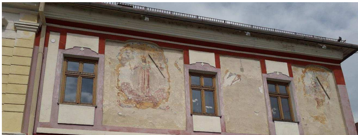
14. ábra: Vonóvasakkal megerősített, téglából épült lakóház, Rimaszombat
