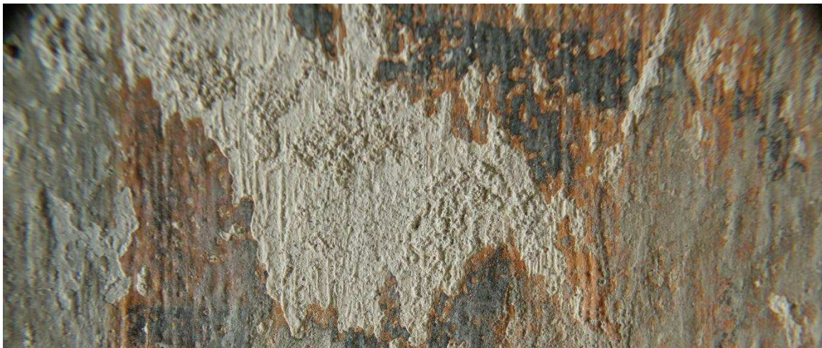
21. ábra: Schlämme réteg a festékréteg alatt, Ráday-kastély, Pécel
