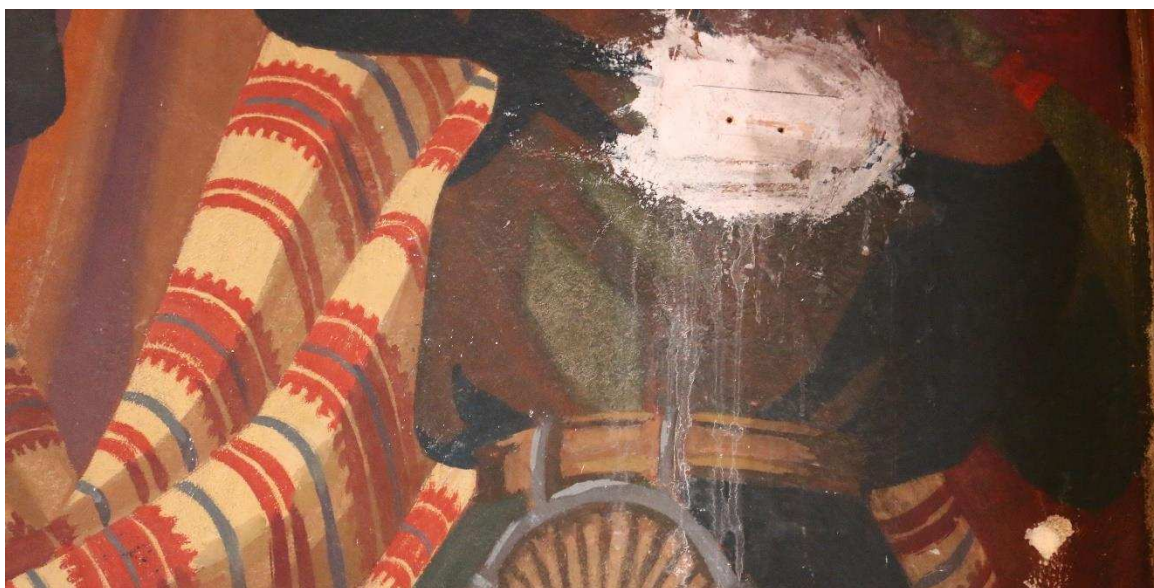
78. ábra: Glettként alkalmazott gipsz megcsorgása a felületen,, Péterfy Sándor utcai Kórház rendelőintézet és Baleseti Központ, Tanácsterem, Budapest, VII. kerület
